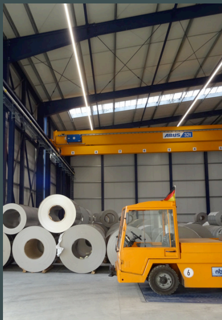
Das neue Hallen-Lichtband "Extrem Power" von Wasco leuchtet Hallen hell, homogen und schattenfrei aus. (Bild: Wasco)
